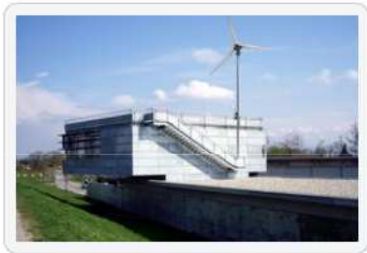
Betriebszentrale Rheinpolder Söllingen Greffern mit feuerverzinkter Blechfassade
