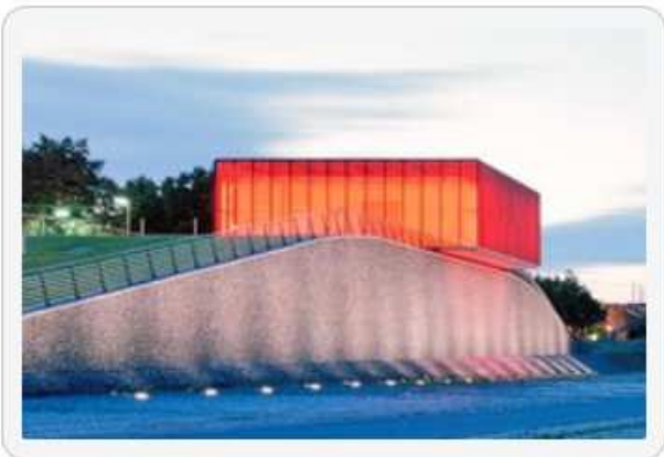
Hochwasserpumpwerk der Stadt Köln mit feuerverzinkter Gitterrostfassade
