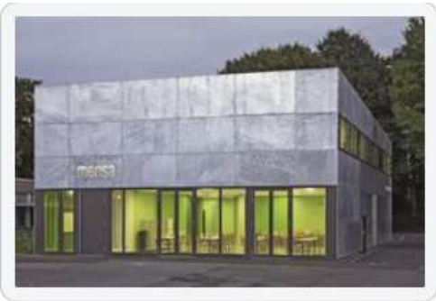
Mensa der Werner-von-Siemens-Schule, Bochum mit feuerverzinkter Blechfassade
