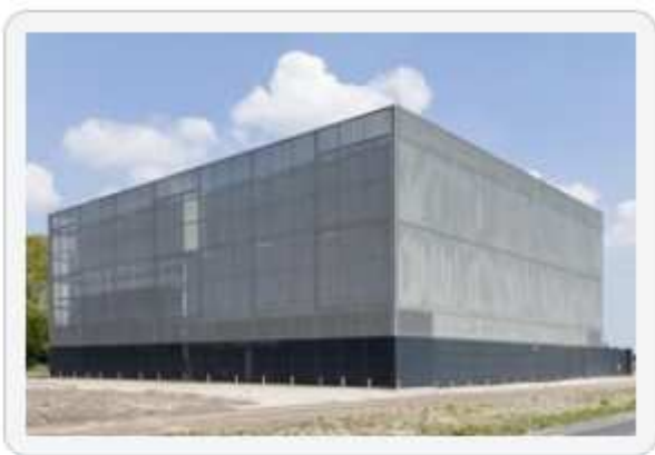
Rechenzentrum in Delft mit feuerverzinkter Elechprofilfassade
