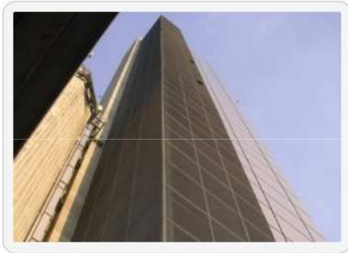
Silo Schapfenmühle mit feuerverzinkter Gitterrostfassade
