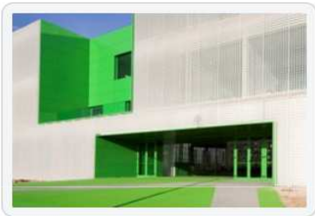
Feuerverzinkte und beschichtete Gitterrostfassade des Sozial-Zentrums in Móstoles
