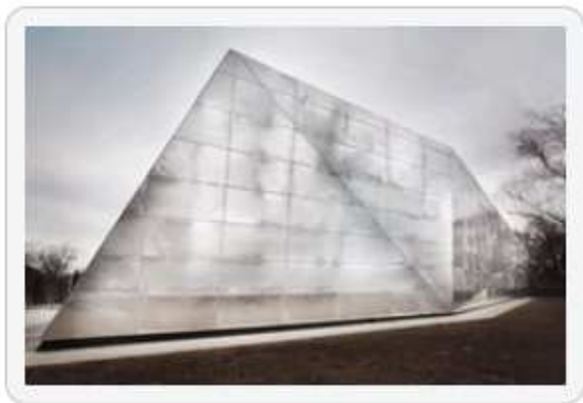
Supermarkt in Graz mit feuerverzinkter Blechfassade
