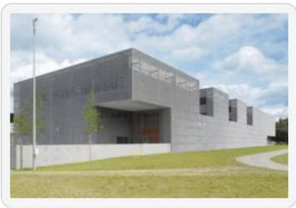
Technisches Betriebszentrum der Stadt München mit feuerverzinkter Streckmetallfassade
