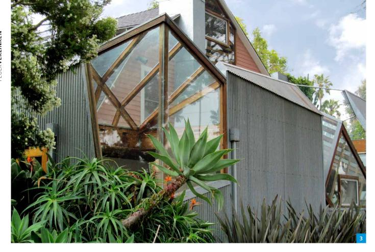
nieur Stanislaus Sorel ermöglichte dem Feuerverzinken durch sein Patent zur Vorbehandlung von Stahl- und Eisenteilen erstmals eine breite, industrielle Anwendung. Wellbleche gehörten zu den ersten feuerverzinkten Bau-Serienprodukten und wurden durch Feuerverzinken zu einem langlebigen Bauelement.
