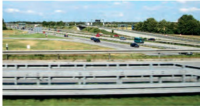
→ Feuerverzinkte Schutzplanken (Foto: H. E. Balling/PIXELIO)
