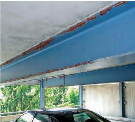
➔ Korrosion an beschichteten Stahlträgern eines Parkhauses
