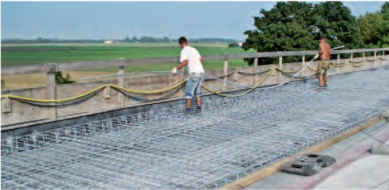
→ Feuerverzinkte Bewehrung einer Brückenkappe an der A99
