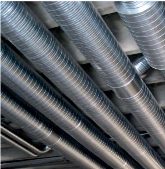
➔ Bandverzinkte Entlüftungsröhre
