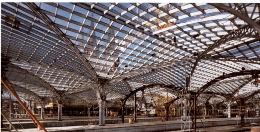
Abb. 9: Die fertiggestellten Vorhallendächer.
