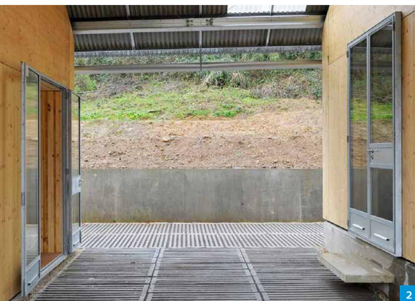
für die Aufbewahrung von Papier von besonderer Bedeutung ist. Eine Lücke zwischen den Holzelementen und der Dacheindeckung sorgt in den warmen Sommermonaten zusätzlich für Luftzirkulation und verhindert eine Überhitzung.
