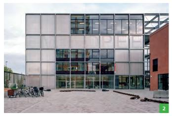
**1+2** Ein Raster-Tragwerk aus feuerverzinktem Stahl dient der Konstruktion und der Gestaltung des Gebäudes.
