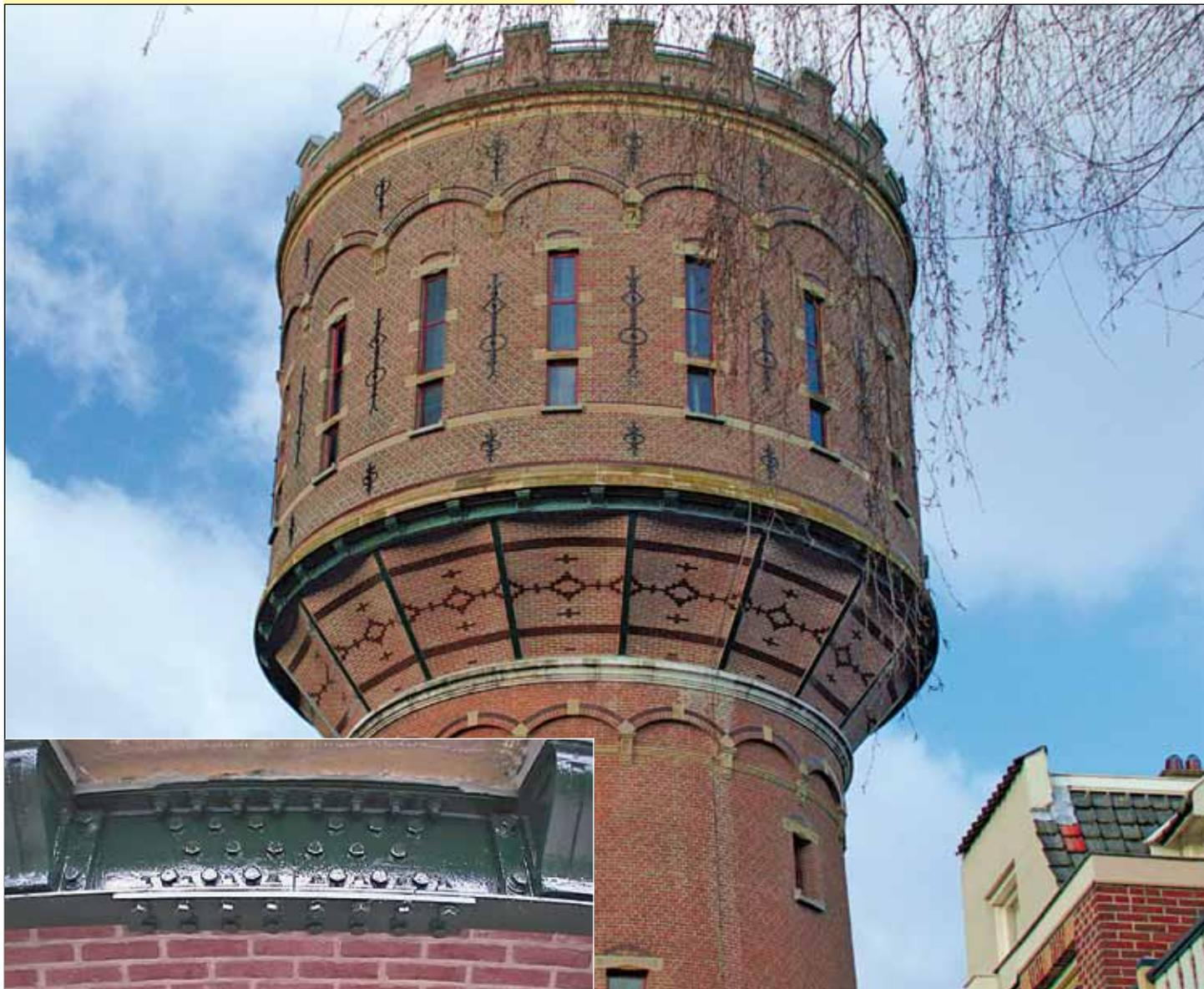
Im Jahr 1903 wurde im niederländischen Baarn ein 18 Meter hoher Wasserturm errichtet. Das Bauwerk besteht aus einer sich nach oben verjüngenden, gemauerten Säule mit einem kreisförmigen Querschnitt, auf der sich ein Wasserreservoir mit einem Fassungsvermögen von 500 m<sup>3</sup> befindet.
