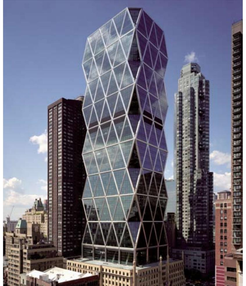
Der Hearst Tower ist derzeit eines der nachhaltigsten amerikanischen Bürogebäude, zu über neunzig Prozent mit recyceltem Stahl gebaut und so konzipiert, dass durch das Auffangen und Aufbereiten von Regenwasser jährlich 7,7 Millionen Liter Wasser gespart werden.
