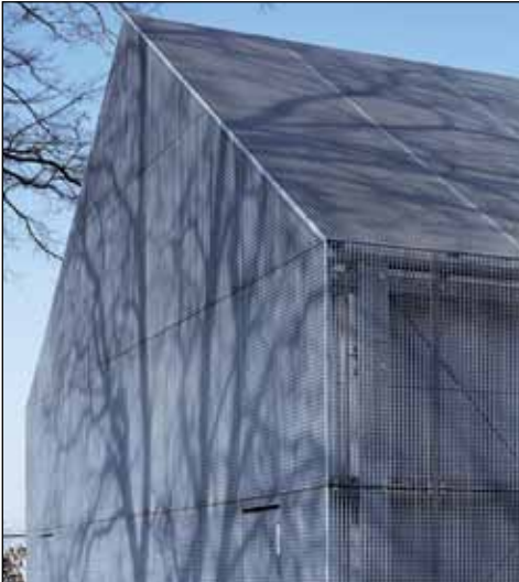
3 Feuerverzinkte Gitterrost-Fassade
