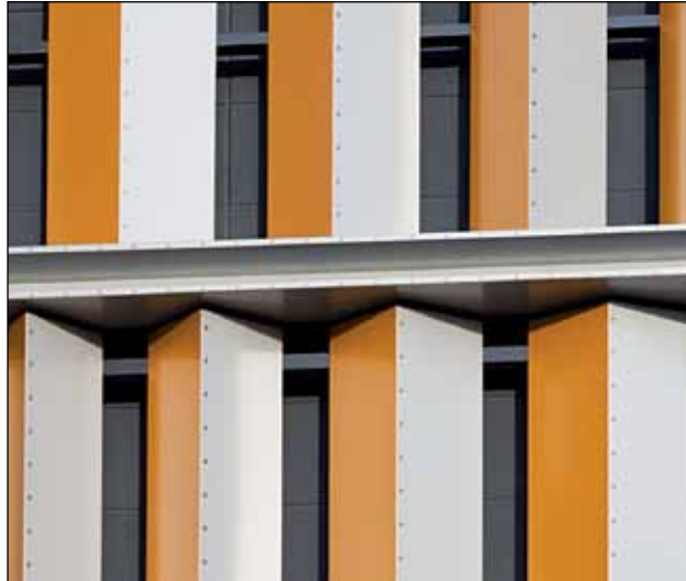
4 Aluminium-Fassade mit feuerverzinkter Tragkonstruktion
