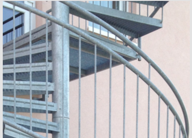
Abb. 3: Gebogenes Geländer einer feuerverzinkten Wendeltreppe.
