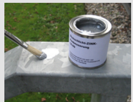
Abb. 2: Die Ausbesserung mit Zinkstaubbeschichtungen mittels Pinsel ist praxisbewährt und zu empfehlen.
