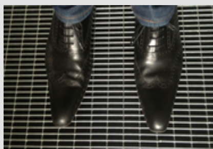
Abb. 3: Beispiel für mechanische Belastbarkeit: Feuerverzinkter Gitterrost.
