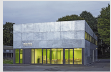
Abb. 3: Ein Werkstoff für die Fassade: Bekleidung, Unterkonstruktion und Verbindungsmittel werden feuerverzinkt.
