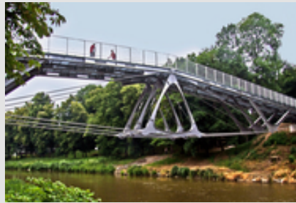
Abb. 2: Der Stahlbau gehört zu den Domänen des Feuerverzinkens.
