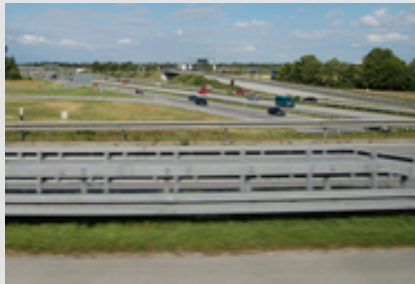
➔ Abb. 5: Von der Schutzplanke bis zum LKW-Trailer - in der Verkehrstechnik wird bevorzugt feuerverzinkt
