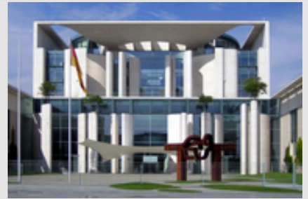
➔ Abb. 6: Bundeskanzleramt: Feuerverzinkter Betonstahl wird oft für Weissbeton-Fassaden verwendet.
