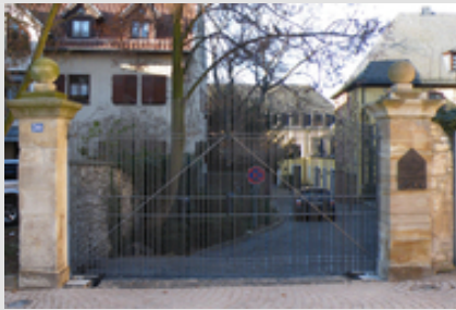
Abb. 1: Metallbau-Konstruktion werden zumeist feuerverzinkt.
