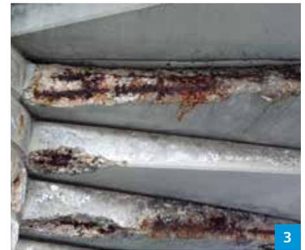
Durch die Verwendung feuerverzinkter Betonstähle wird die Dauerhaftigkeit von chloridbelasteten Konstruktionen und Bauteilen deutlich verbessert. Hierzu gehören in besonderem Maße maritime Bauwerke sowie Bauten die unmittelbar oder in Form von Sprühnebel und Spritzwasser durch Tausalze belastet werden (Tabelle 1).
