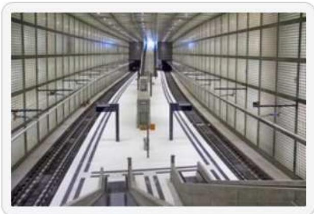
Citytunnel-Station Wilhelm-Leuschner Platz in Leipzig mit feuerverzinkter Fassaden-Unterkonstruktion
