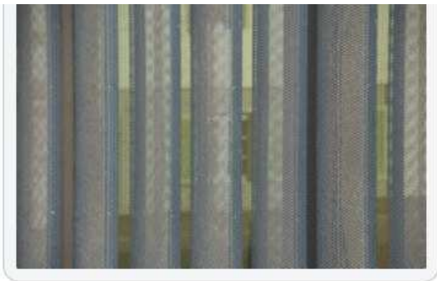
Kunstgalerie Stihl in Waiblingen mit Lamellenfassade aus feuerverzinktem Streckmetall
