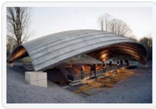
Selbsttragende, feuerverzinkte Dachschaale St. Antony, Oberhausen
