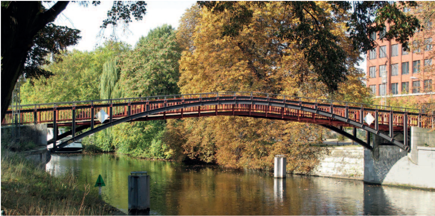
➔ Duplex-beschichtete Fußgängerbrücke Hiroshimasteg
