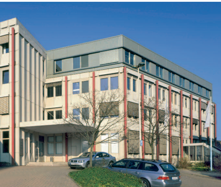
➔ Stahlzentrum Düsseldorf mit duplex-beschichteter Fassade. (Foto: Wirtschaftsvereinigung Stahl)
