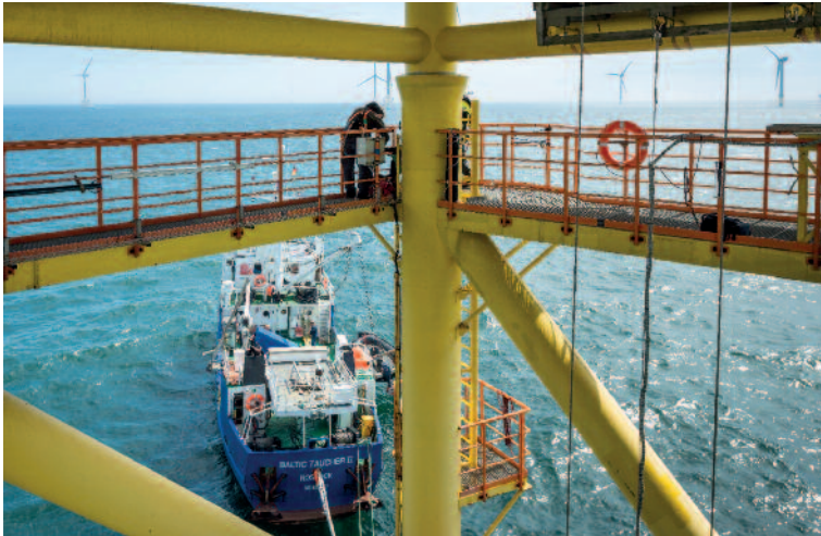
➔ Die duplex-beschichteten Bauteile der Offshore-Forschungsstation Fino I sind nach 10 Jahren mängelfrei, während die nur beschichteten Stahlbauteile Korrosionserscheinungen aufweisen. (Fotos: Holger Vonderlind)
