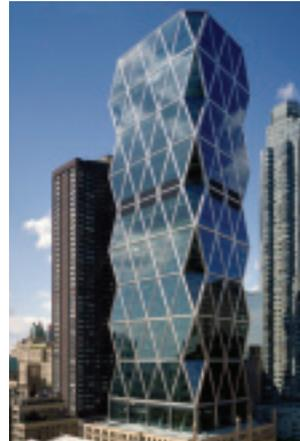
Der Hearst Tower ist derzeit eines der nachhaltigsten amerikanischen Bürogebäude, zu über neunzig Prozent mit recyceltem Stahl gebaut und so konzipiert, dass durch das Auffangen und Aufbereiten von Regenwasser jährlich 7,7 Millionen Liter Wasser gespart werden.
