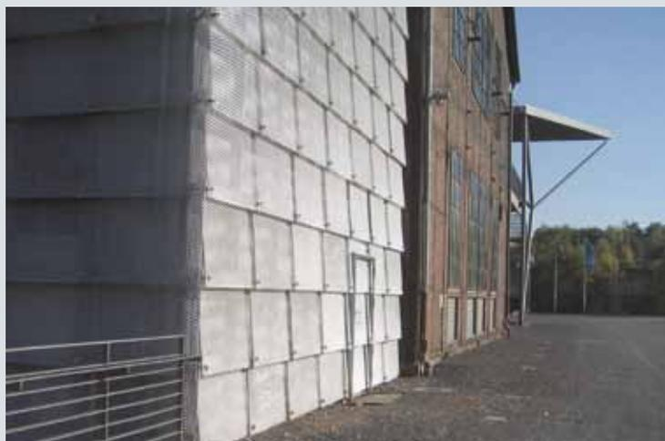
Da Streckmetall eine vergleichsweise hohe Festigkeit und Flächenstabilität besitzt, ist das Aufschweißen von Versteifungsstegen, um den Blechen mehr Stabilität zu verleihen, nicht notwendig. Zudem ist zumeist der Gewinn an Steifigkeit relativ gering, das Risiko von Verwerfungen beim Feuerverzinken nimmt jedoch aufgrund der zusätzlichen Schweiß-
