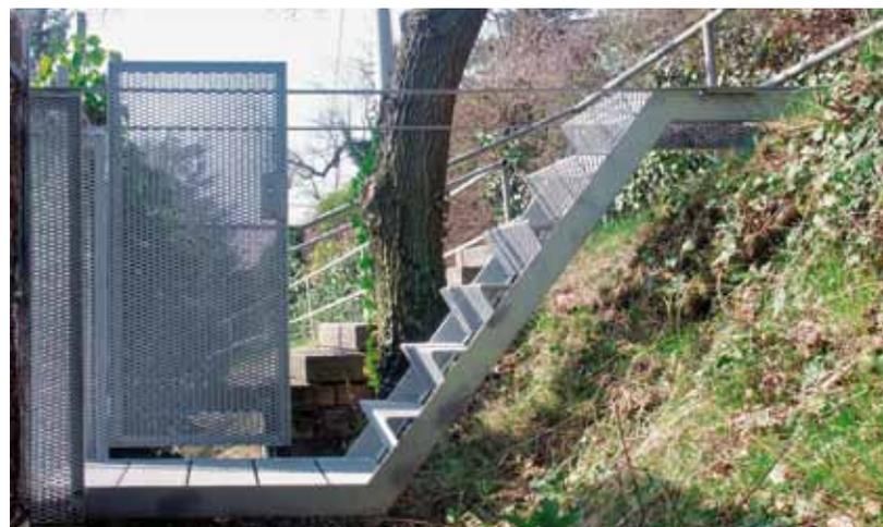
Seiten der Mauer krägt die Treppe aus und schwebt über dem Gelände. Mittels Spannelementen aus Flachstahl werden die Kräfte über zwei Pylone in die Stützwand eingeleitet. Die Pylone sind zudem die Flanken der Eingangstüre. Sämtliche Elemente der Konstruktion wurden in feuerverzinktem Stahl ausgeführt. Der 3-fach geknickte Treppenlauf ist
