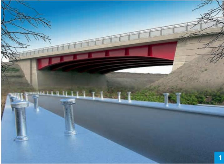
1 | *Feuerverzinkte Stahl- und Verbundbrücken können heute schon mit Zustimmung im Einzelfall realisiert werden.*
