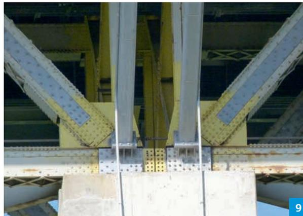
**8 |** 1969 wurde die vierspurige beschichtete Brücke mit feuerverzinktem Stahl auf sechs Spuren erweitert.
