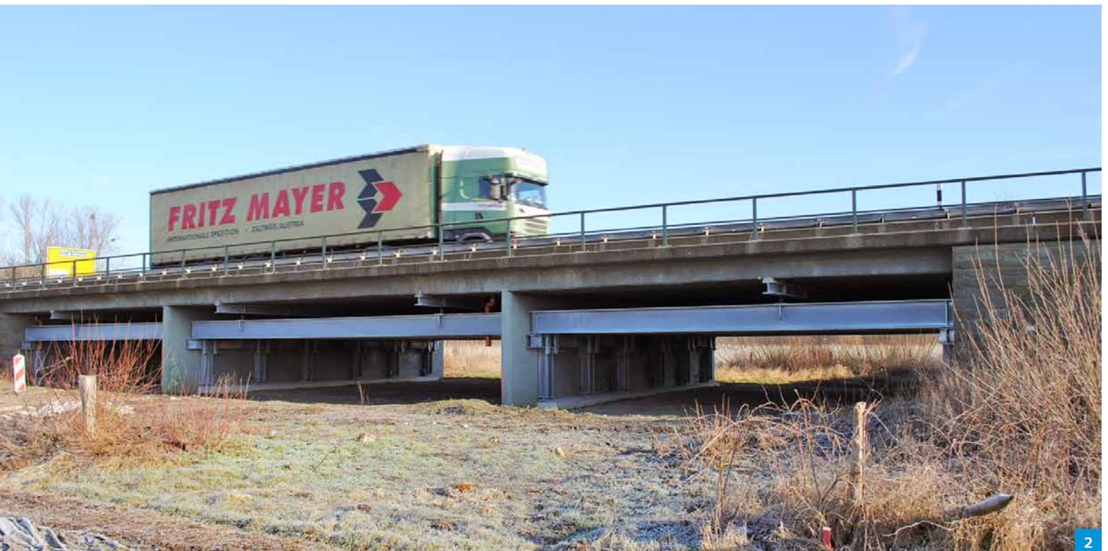
Die Ertüchtigung von drei Brücken auf der vierspurigen B 55-Umgehung in Lippstadt ist ein gutes Beispiel. Aufgrund nicht mehr ausreichender Tragfähigkeit für die heutigen Belastungen des Schwerverkehrs wurden die Lippebrücke, die Lippe-Umflutbrücke sowie die Brücke über die K 34 am Margaretensee rund um Lippstadt für LKW über 7,5 t gesperrt. Um die Sperrung möglichst schnell aufzuheben und für LKW bis 44 Tonnen wieder befahrbar zu machen, wurden die Brücken temporär ertüchtigt.
