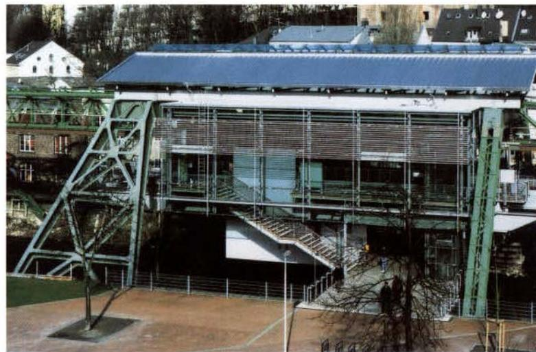
Auseinandersetzung mit der Konstruktion an sich. Die sorgfältige Planung sämtlicher Details, die Leichtigkeit der Haltestelle und die scheinbare Entmaterialisierung insbesondere durch die Beleuchtungseffekte bei Nacht waren für die Entscheidung der Jury von Bedeutung. Über die Planung von Details hinaus war für die Architekten die Feuerverzinkung in Verbindung mit zusätzlichen Farbbeschichtungen ein wesentlicher Garant der sicheren zukünftigen Nutzung.
