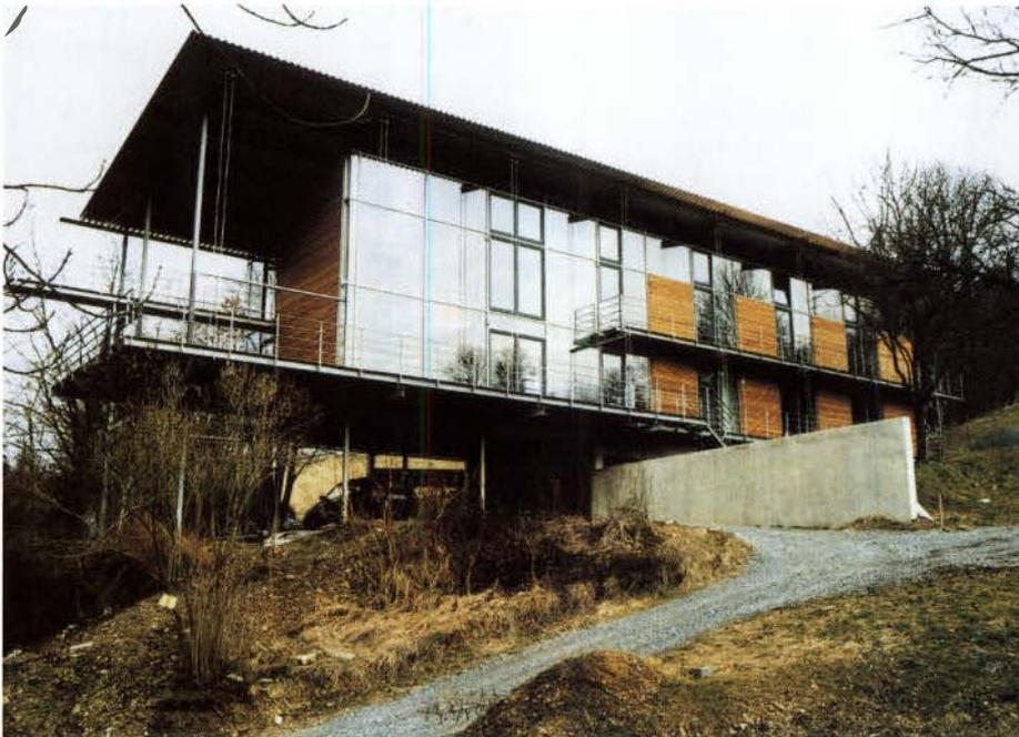
Das feuerverzinkte Stahlskelett, das mit seinen tragenden und aussteifenden Elementen auch im Innenbereich sichtbar bleibt, zeigt in seinem sorgfältigen Zusammenwirken mit Holzpaneelen und glatten Wandflächen, dass verzinkter sichtbarer Stahl sich auch hervorragend für eine wohnliche, räumliche Gestaltung eignet. Es wäre wünschenswert, wenn dieses Haus mit seiner materialgerechten und beispielhaften Gestaltung richtungweisend für den Wohnungsbau würde.
