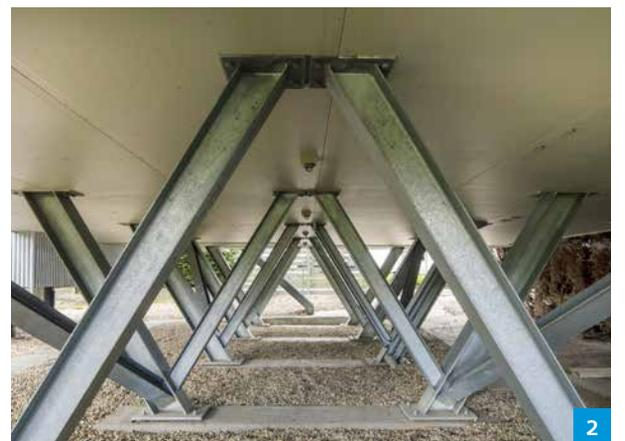
1 | *Feuerverzinkter Stahl dient als Korrosionsschutz und Gestaltungselement.*
