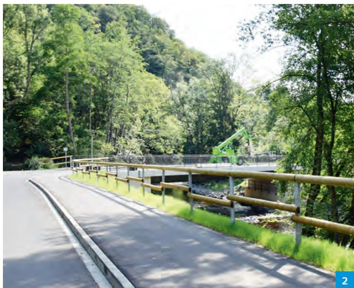
1 | *Die feuerverzinkte Stahlverbundbrücke hat eine marode Stahlbetonbrücke ersetzt.*
