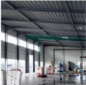
Abb. 1: Hallenkonstruktion mit R30-Brandschutz durch Feuerverzinken.
