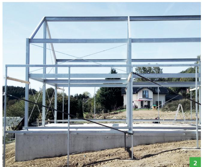
**1+2** | *Eine filigrane, feuerverzinkte Stahlskelett-Konstruktion bildet das Tragwerk des Hauses.*
