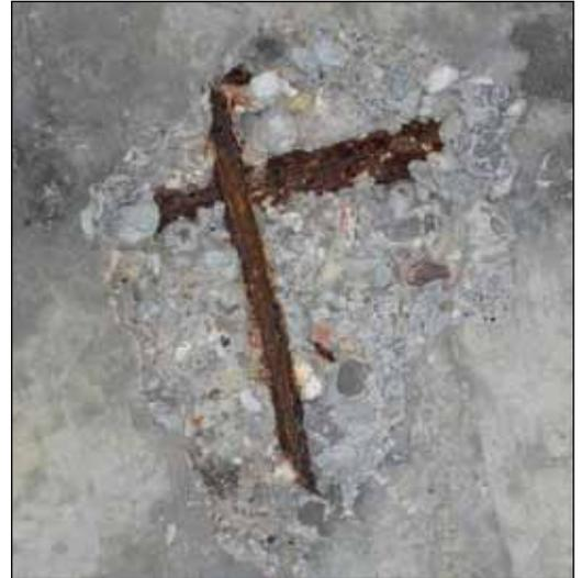
An der Bundesautobahn A99 mussten im Jahr 2009 umfassende Instandsetzungsarbeiten an Brückenbauwerken durchgeführt werden. Besonders stark betroffen waren die „verwitterten“ Brückenkappen, die durch die Korrosion des Bewehrungsstahls besonders in Mitleidenschaft gezogen wurden.
