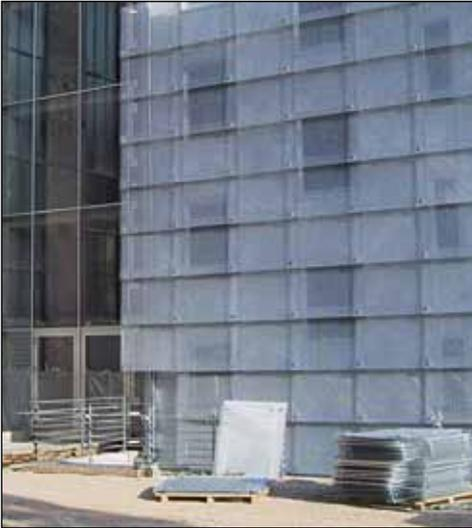
2 Steuerbare Lamellenfassade mit feuerverzinkter Unterkonstruktion
