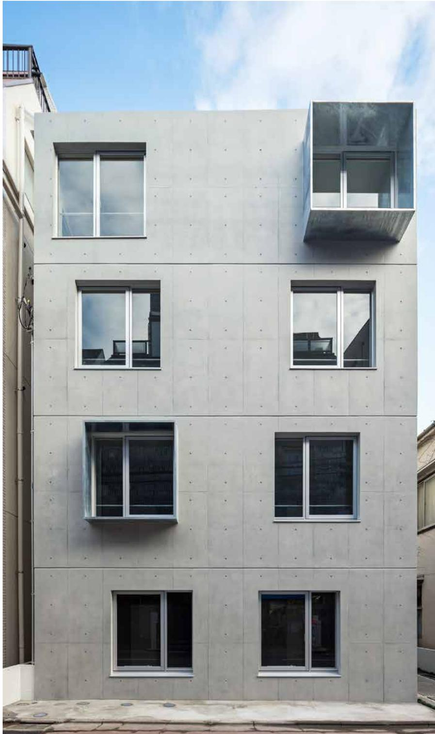
An einer belebten Einkaufsstraße im südlichen Tokio entstand ein viergeschossiger Sichtbetonkubus mit zwölf Wohneinheiten. Das minimalistische, eigentlich unauffällige Gebäude mit einer klar gegliederten Fassade besticht durch seine Fensterelemente, die dem Gebäude einen uneinheitlichen Ausdruck geben.
