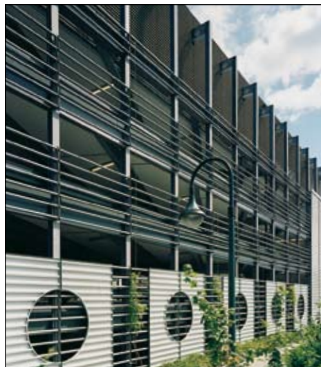
4 Ein mittelschwerer Stahlbau wurde untersucht
