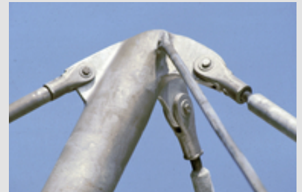
➔ Abb. 3: Gabelköpfe und Haltesysteme sind zumeist aus feuerverzinktem Gussstahl.
