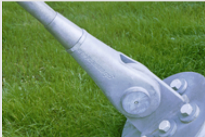
➔ Abb. 1: Gussteile werden seit langem feuerverzinkt ausgeführt.
