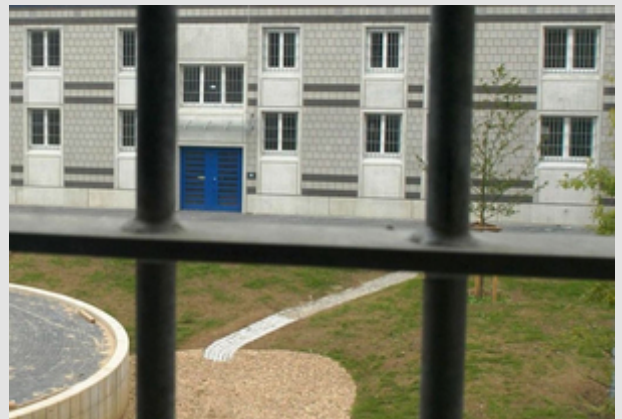
Abb. 4: Feuerverzinkte Manganhartstähle werden in Justizvollzugsanstalten eingesetzt.
