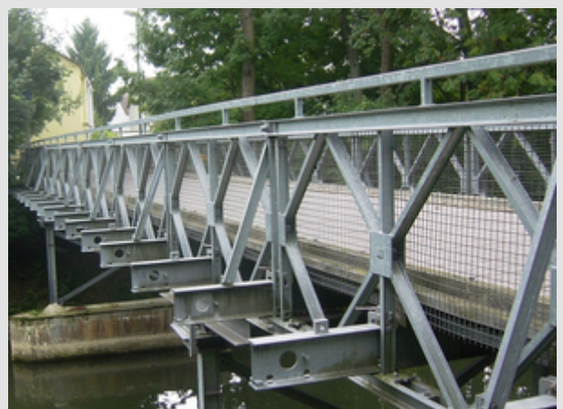
Abb. 2: Alte, beschichtete Bailey-Brücken konnte nachträglich feuerverzinkt werden.
