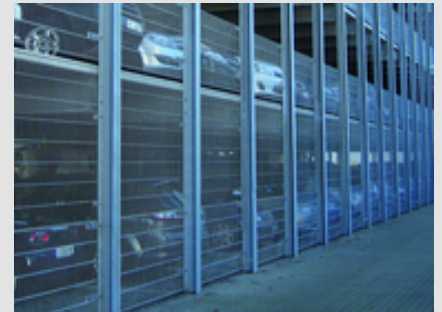
Abb. 6: Feuerverzinkter Stabgitterzaun an einem Parkhaus
