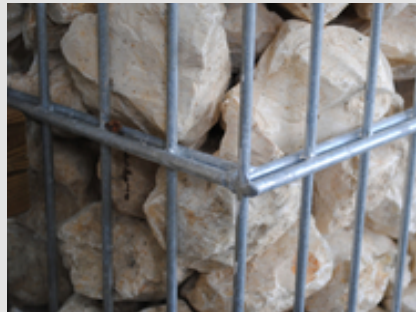
Abb 5: Feuerverzinkte Gabionenkörbe werden immer beliebter.
