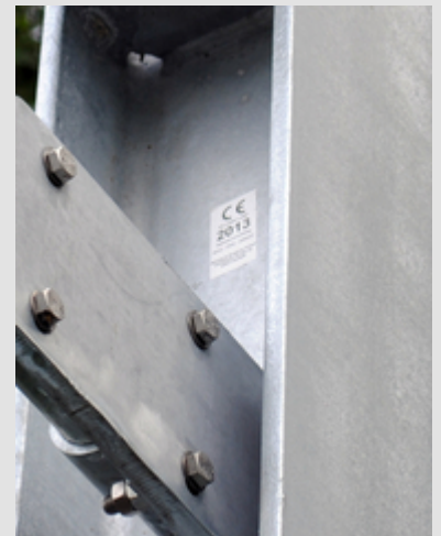
Abb. 4: Verbindungsmittel aus nichtrostendem Edelstahl in feuerverzinkter Stahlkonstruktion
