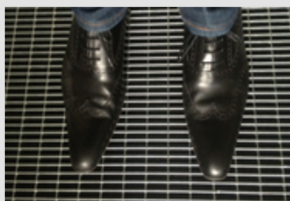
Abb. 3: Beispiel für mechanische Belastbarkeit: Feuerverzinkter Gitterrost.
