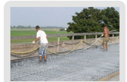
Abb. 2: Feuerverzinkter Betonstahl nach bauaufsichtlicher Zulassung Z-1.4-165
