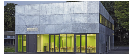
Abb. 3: Ein Werkstoff für die Fassade: Bekleidung, Unterkonstruktion und Verbindungsmittel werden feuerverzinkt.
