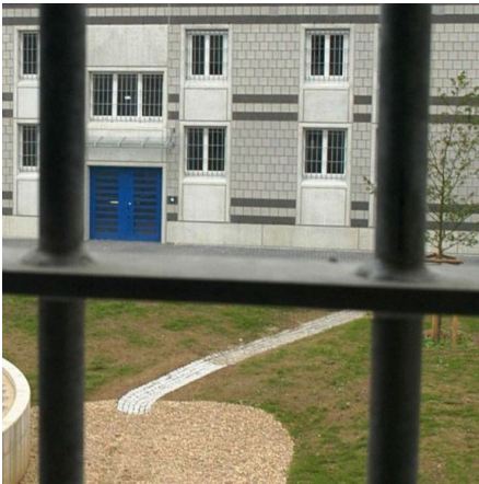
Abb. 4: Feuerverzinkte Manganhartstähle werden in Justizvollzugsanstalten eingesetzt.
