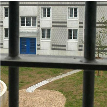
Abb. 4: Feuerverzinkte Manganhartstähle werden in Justizvollzugsanstalten eingesetzt.
