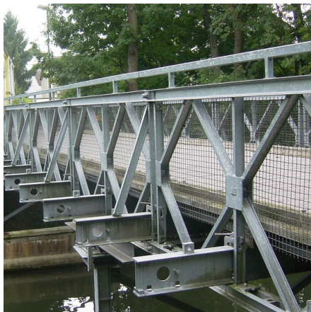
Abb. 2: Alte, beschichtete Bailey-Brücken konnte nachträglich feuerverzinkt werden.
