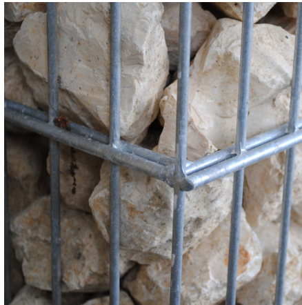
Abb 5: Feuerverzinkte Gabionenkörbe werden immer beliebter.
