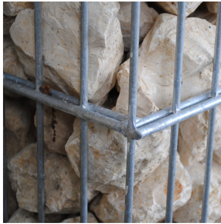
Abb 5: Feuerverzinkte Gabionenkörbe werden immer beliebter.
