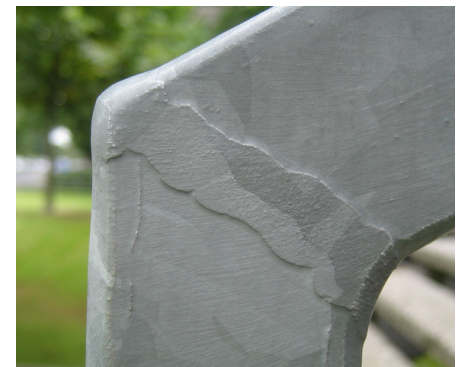
Abb. 3: Aufgewachsener Zinküberzug an blecheben geschliffenen Schweißnähten aufgrund hohen Siliziumgehaltes in der Schweißnaht.
