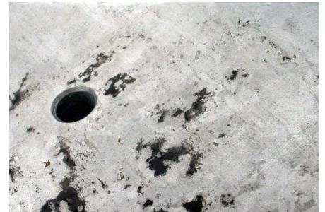
Abb. 6: Fehlstellen durch unzureichend entfernte Farbreste.
