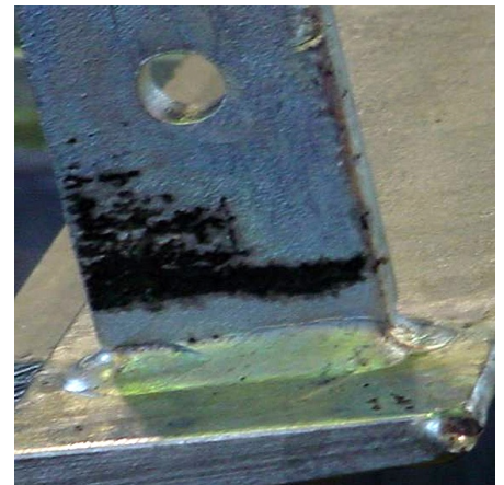
Abb. 3: Nicht entfernte Schweißsprayrückstände verursachen Fehlstellen im Zinküberzug.
