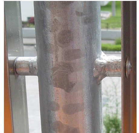
Abb. 3: Leichter Weißrost an einem Zinküberzug
