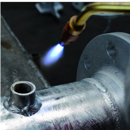
Abb 1: Überflüssige Zinktropfen können mit weicher Flamme abgeschmolzen und danach mit Drahtbürste oder Blechspachtel beseitigt werden.
