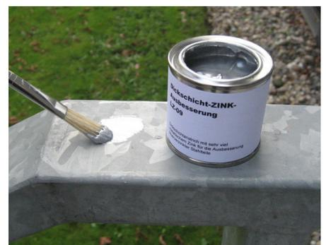
Abb. 6: Fehlstellen fachgerecht ausbessern. Mehr hierzu im Arbeitsblatt E.4.
