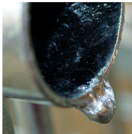
Abb. 2: Abfließendes Zink kann in Form von Tropfnasen und Verdickungen erstarren.
