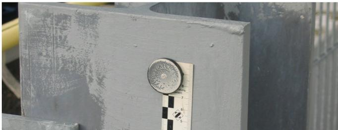
Abb. 3: Falsch: Kleine Fehlstellen werden oft sehr großflächig ausgebessert.
