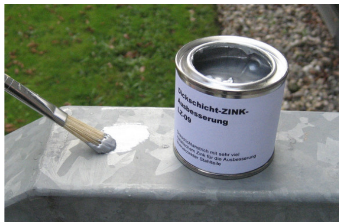
Abb. 2: Die Ausbesserung mit Zinkstaubbeschichtungen mittels Pinsel ist praxisbewährt und zu empfehlen.
